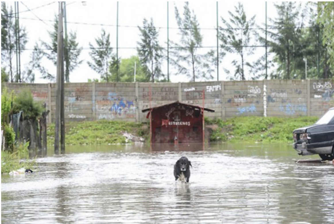
Inundaciones, 2014. De fondo se ve el muro del barrio privado La Comarca, desde su llegada las inundaciones fueron más grandes y frecuentes.
